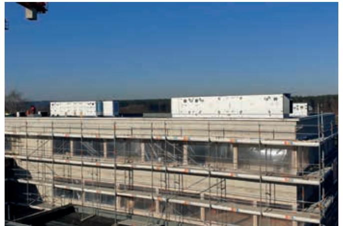
Noch im Februar wurden die Belüftungsanlagen auf dem Dach montiert.
