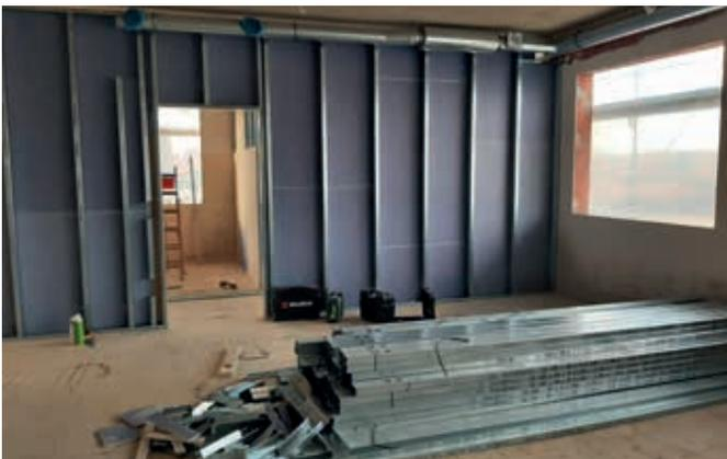
Die ersten Räume konnten in Leichtbauweise mit Gipskartonplatten entstehen.
